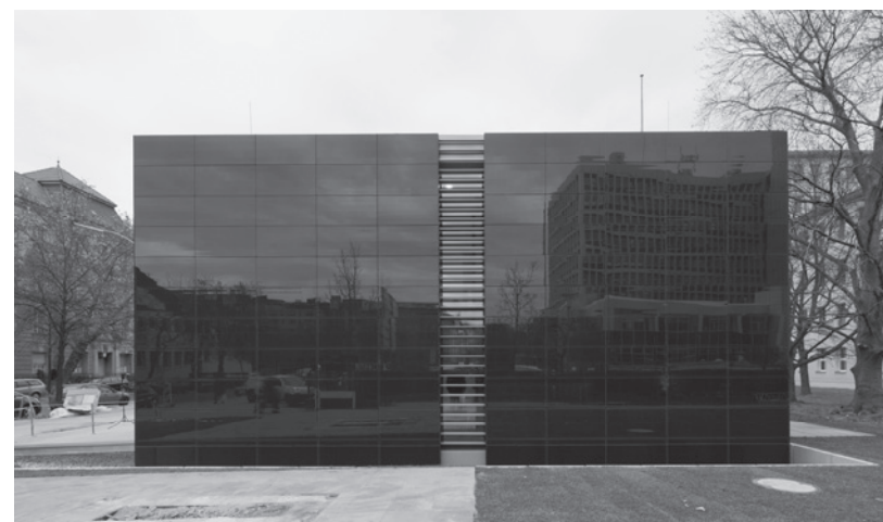
Die Südfassade ist fensterlos und fast komplett mit Photovoltaikmodulen verkleidet.
