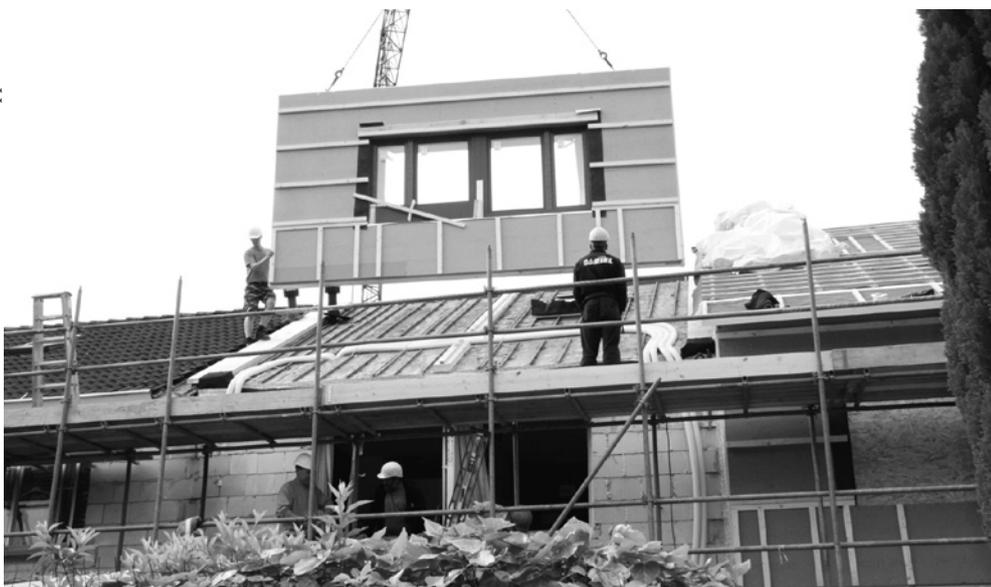
Energetische Modernisierung einer Reihenhaussiedlung in Tilburg mit vorgefertigten Großelementen. Die Methodik erwarb das ausführende Holzbauunternehmen Gump & Maier im Rahmen des europäischen Forschungsprojekts „TES EnergyFacade“. Infos: [www.tesenergyfacade.com](http://www.tesenergyfacade.com)
