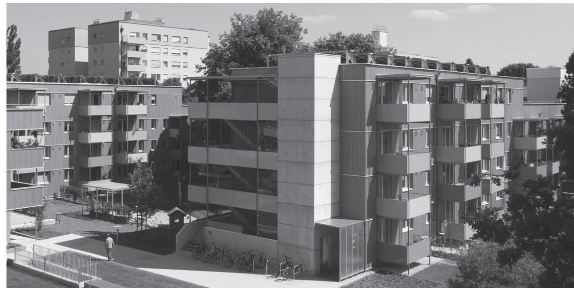
Gesamterneuerung einer ursprünglich dreigeschossigen 1950er-Jahre-Wohnanlage in München-Sendling. Neben der Energetischen Modernisierung mit vorgefertigten Fassadenelementen in Holzrahmenbauweise wurden die Gebäude um ein Geschoss aufgestockt, durch einen Neubau ergänzt und ihre Treppenhäuser durch Laubengänge ersetzt. Ausführliche Infos: www.gwg-muenchen.de → Bauen und Wohnen → Broschüre „Bauen mit Holz – eine überzeugende Ökobilanz“ (PDF-Download)
