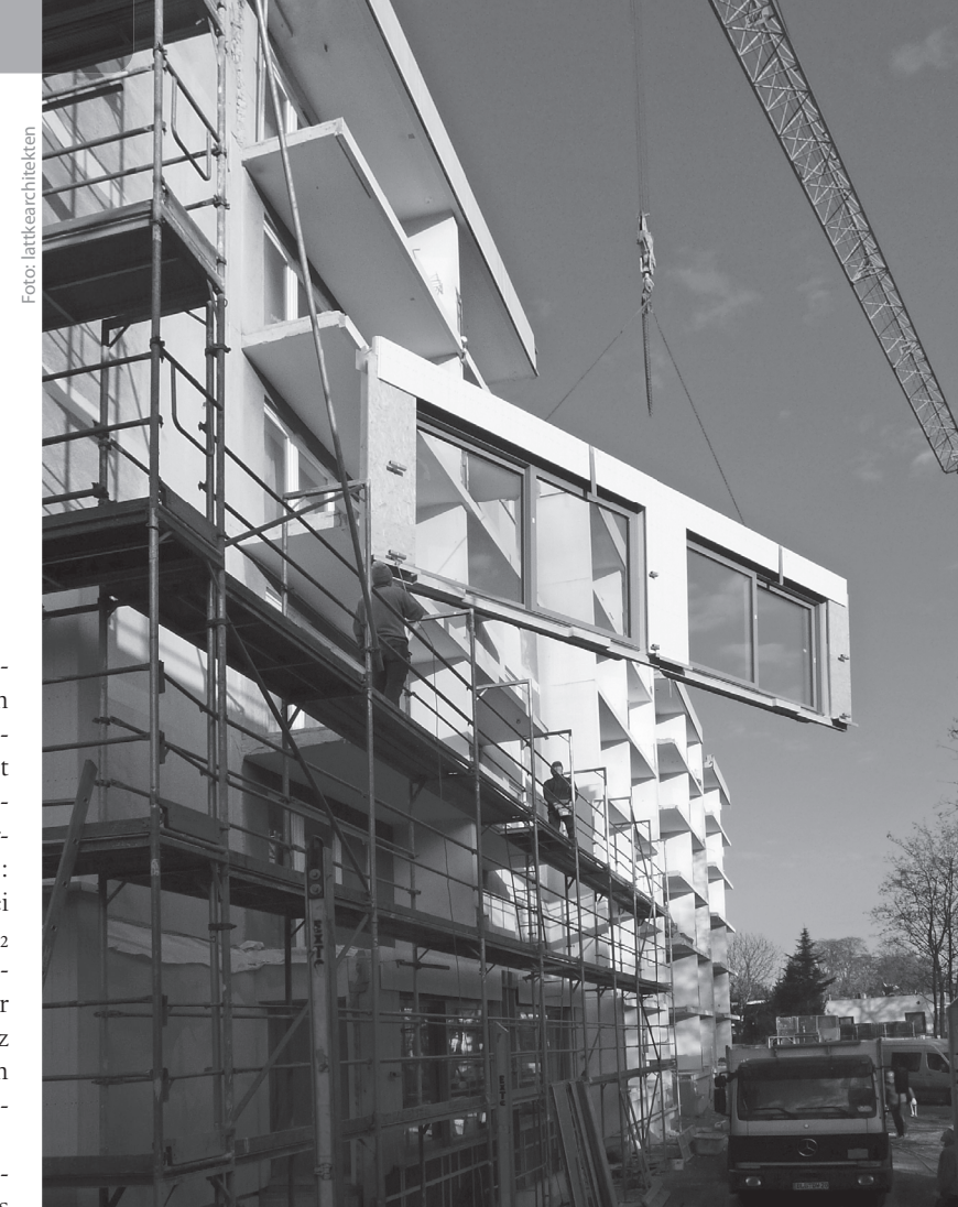
Energetische Modernisierung eines sechsgeschossigen 1970er-Jahre-Wohngebäudes in Augsburg-Hochzoll mit vorgefertigten Fassadenelementen in Holzrahmenbauweise. Diese Methode wurde im europäischen Forschungsprojekt „TES EnergyFacade“ wissenschaftlich untersucht und weiterentwickelt. Ausführliche Infos: www.tesenergyfacade.com → Downloads → Article about TES in Mikado Magazine (PDF-Download)
