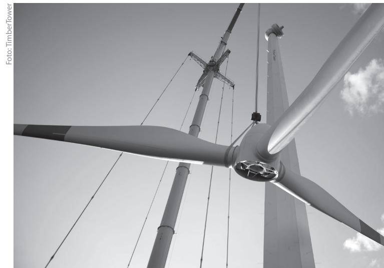
Zum Schluss wird der Rotor montiert. Dessen Bewegungen lassen Stahl schneller ermüden als Holz.
