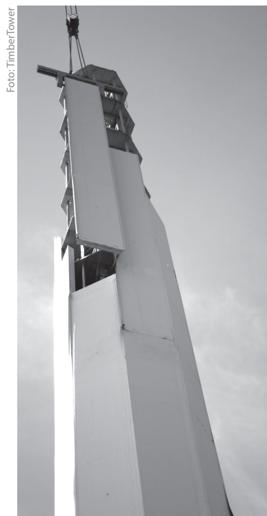
Die Lasten werden später ausschließlich von den Brettsperrholzplatten nach unten abgetragen.
