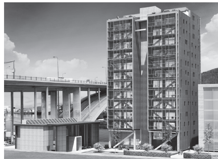
Demnächst fertig ist der Bau des 14-geschossigen Holzhochhauses „Trehus“ im norwegischen Bergen. Es beherbergt 62 Wohnungen und ist mit seinen 48 m dann für einige Jahre das höchste Holzgebäude der Welt.
