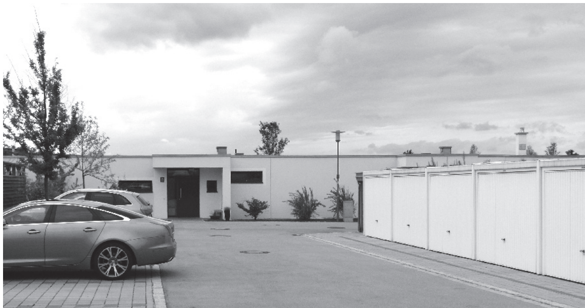
Bungalow-Wohnanlage in Feldkirchen bei München: der Gebäudetyp mit dem höchsten Bodenflächenverbrauch pro m 2 Wohnfläche
