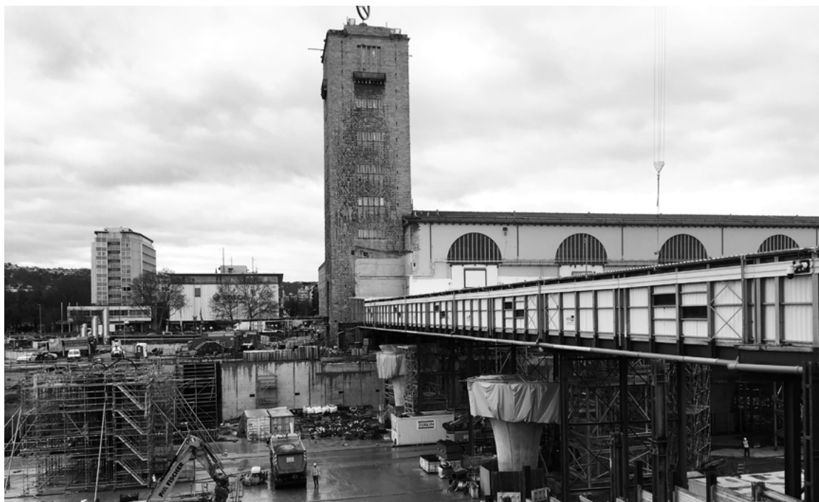
Großbaustelle Stuttgart 21: Seit 2010 wird der oberirdische Kopfbahnhof zu einem unterirdischen Durchgangsbahnhof umgebaut.
